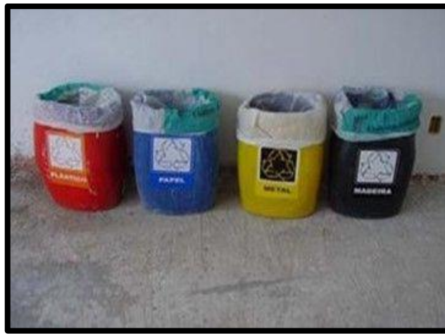
Figura 3. Bombonas utilizadas na separação e acondicionamento dos RCD nos pavimentos.
